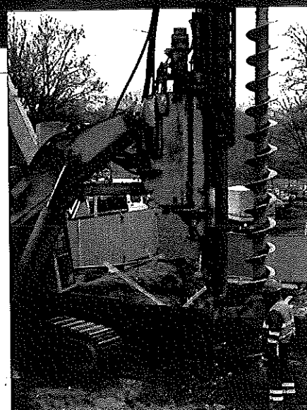
Prace prowadzone przy ulicy Miarki
