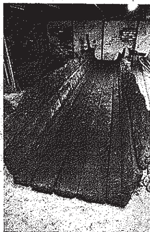
Drewniane koryta służyły do odprowadzania wody spływającej do wyrobiska
