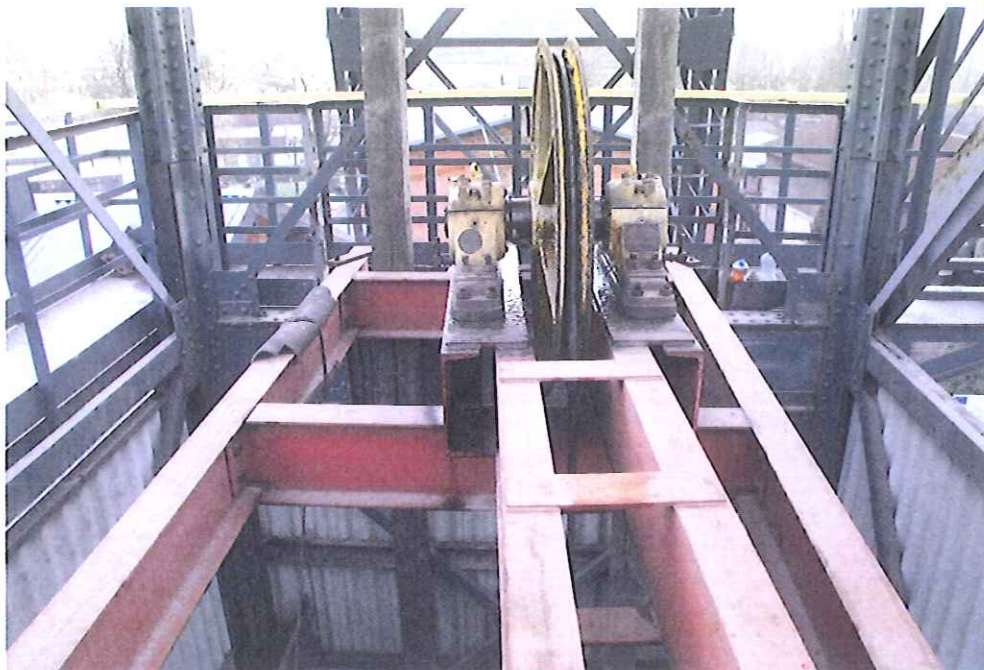
Fot. 8 Przestrzeń do usytuowania maszynowni
