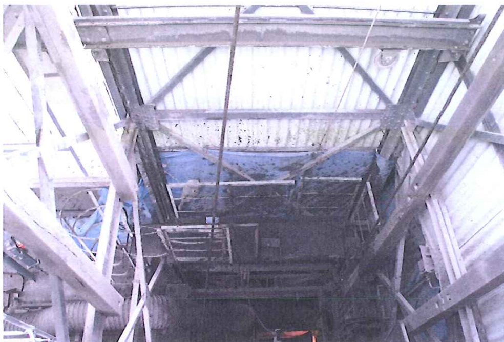
Fot. 9 Przestrzeń docelowego nadszybia i maszynowni
