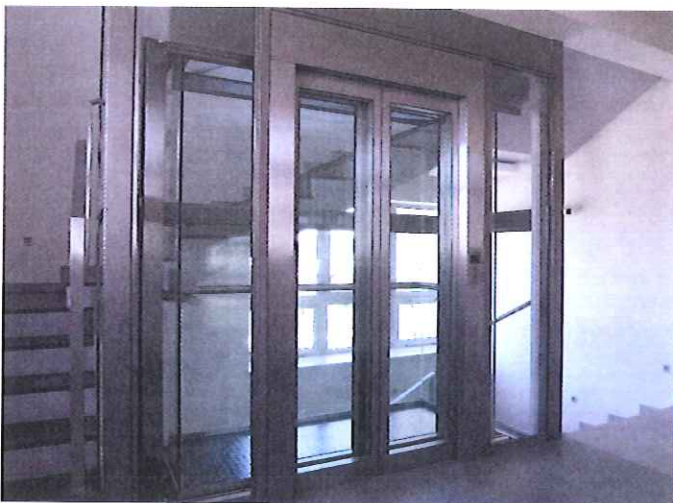
Fot. 4 Drzwi centralnie otwierane, skrzydła przeszklone, szkło objęte ramką na obwodzie (prod. SURSUM)
