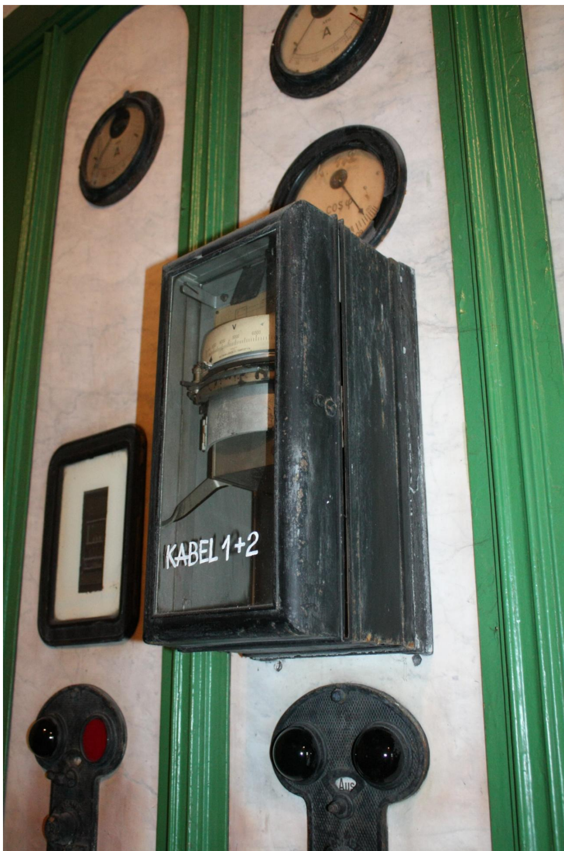
Fot.25 Pole 7 z woltomierzem z zapisem
