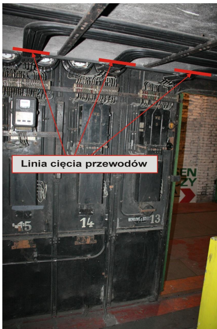
Fot.28 Miejsce cięcia przewodów
