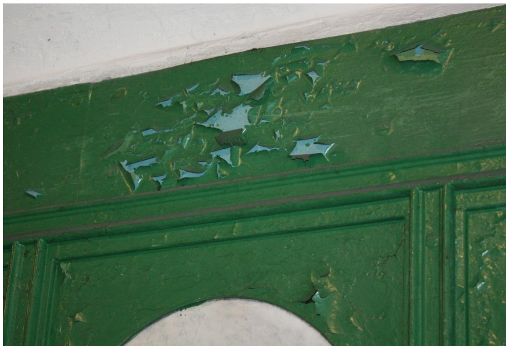
Fot.2 Złuszczenia kolejnych przemalowań
