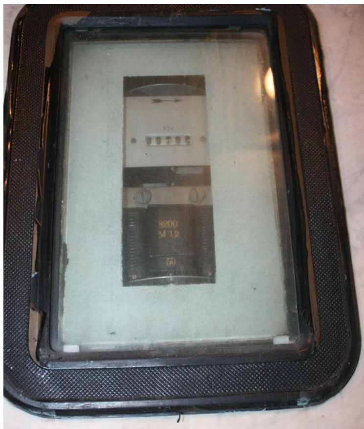
Fot.19 Okienko licznika z ramką mosiężną pierwotnie niklowaną
