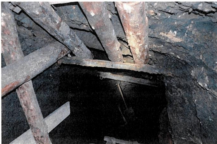
Fot. 1. Widok w kierunku zachodnim. Początkowy odcinek pochylni, widoczna pierwotna obudowa ze stropnic stalowych montowanych w gniazdach ociosowych.
