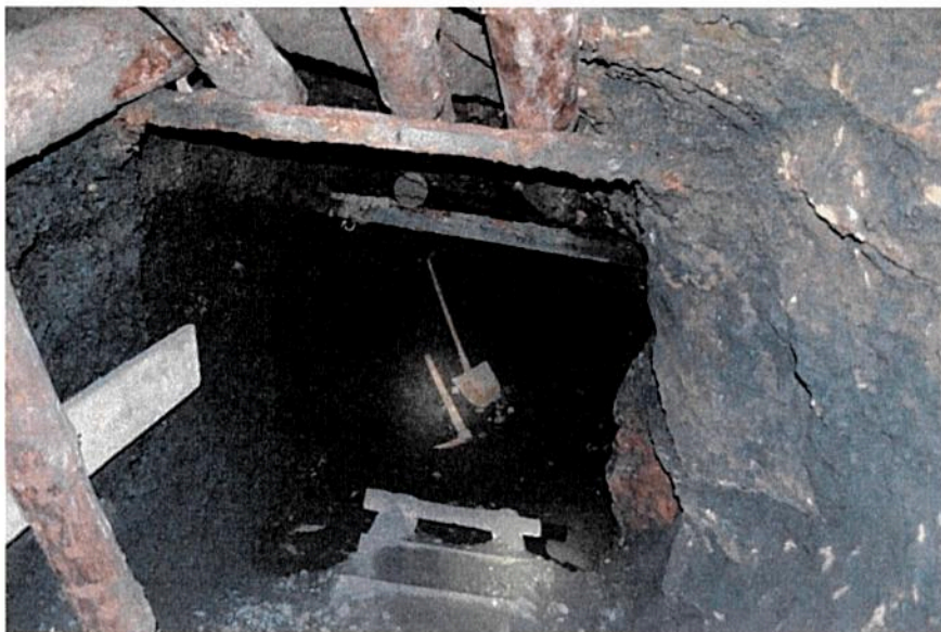
Fot. 2. Widok w kierunku zachodnim. Początkowy odcinek pochylni, widoczna pierwotna obudowa z stropnic stalowych montowanych w gniazdach ociosowych i materiał podsadzkowy na ociosie południowym.
